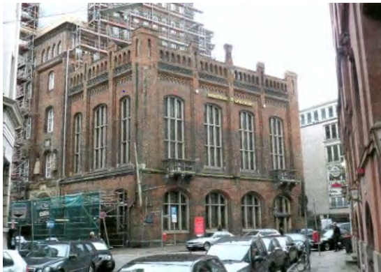
Haus der Patriotischen Gesellschaft während der Sanierungsarbeiten, 2014, Foto: Patriotische Gesellschaft
