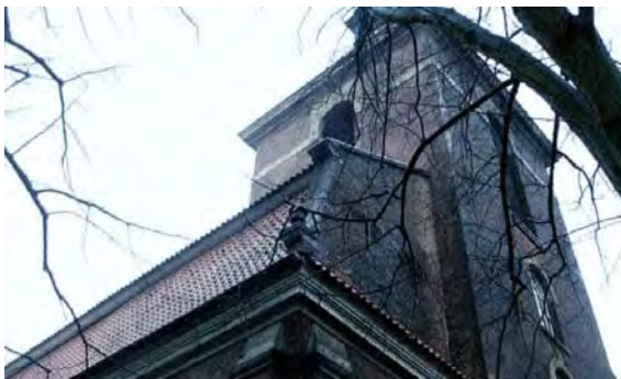
Turm Westansicht, Foto: Ev.-Luth. Kirchenkreis Hamburg-West/Südholstein, Geschäftsbereich Bau & Immobilien, Bauabteilung
